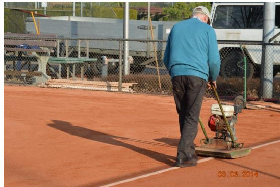
Afbeelding: natrillen met lichte triplaat
