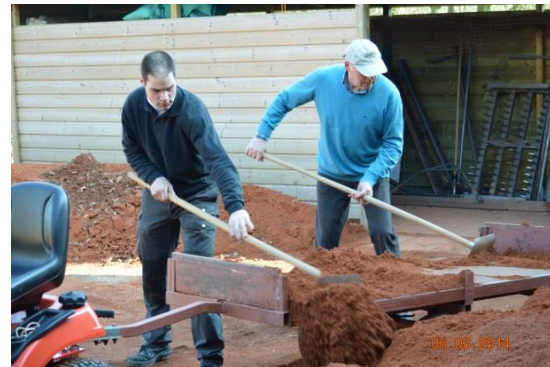
Afbeelding: aanhangwagen voor afvoeren vervuilde gravel
