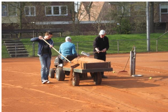
Afbeelding: gravel opbrengen
