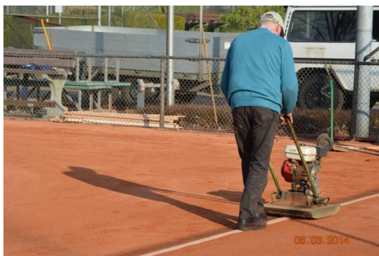
Afbeelding: natrillen met lichte trilplaat
